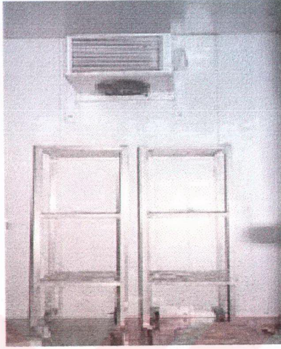
Şekil 2.3: Soğuk depoda ürünlerin muhafaza edilmesi
